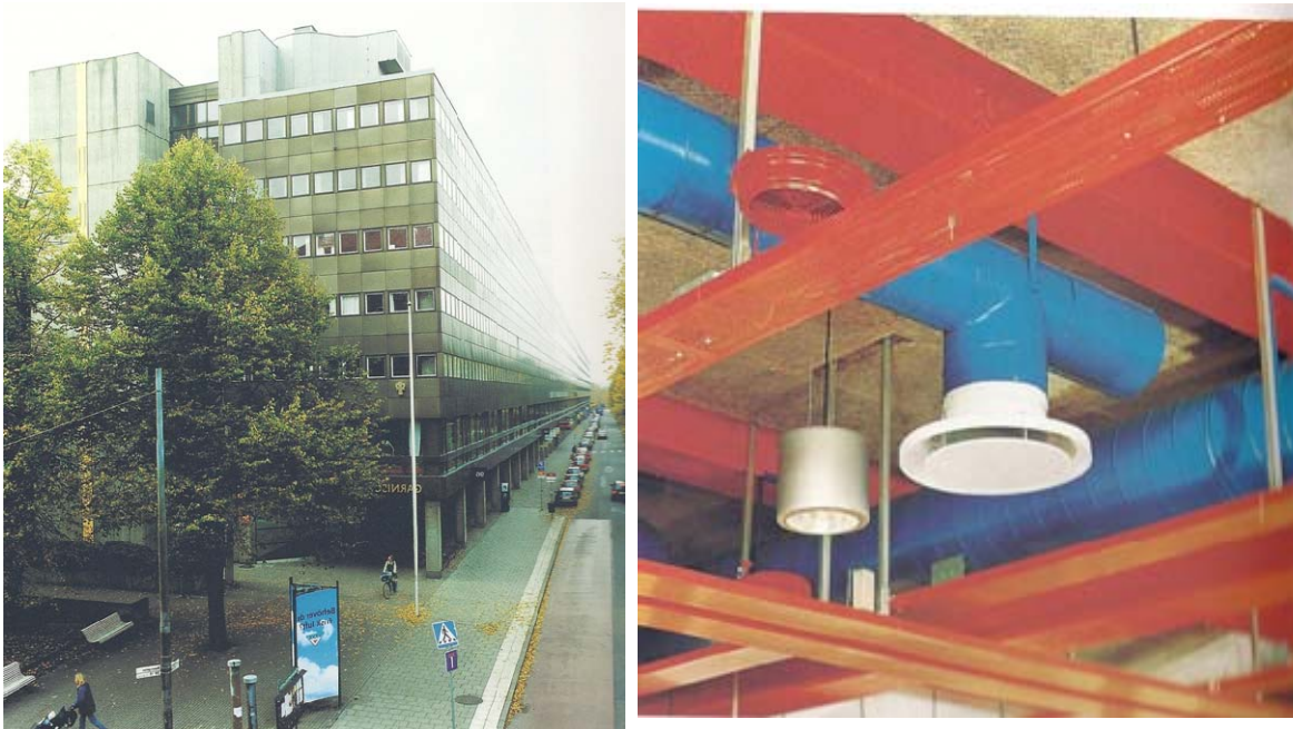
Figur 3 Kv. Garnisonens gatufasad och exempel på fritt placerade installationer
